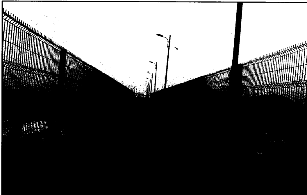
1.- Instalación de Malla Metálica De Protección En Puente Losa De Aproximación
